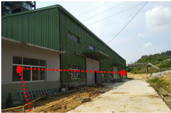
Bukaan pintu dan Gambar 12. Jendela Gedung Workshop Sumber : Data Penulis
