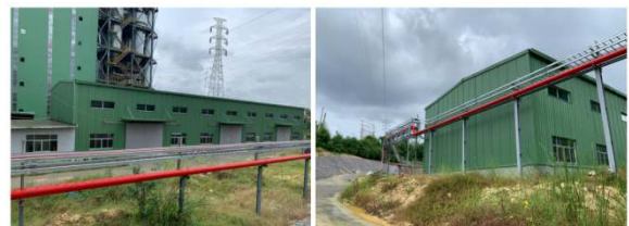
Gambar 17. Pandangan Dari Luar ke Bangunan Sumber : Data Penulis
