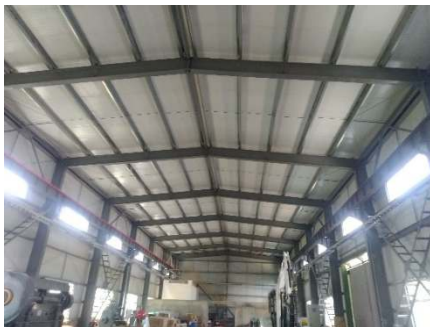
Gambar 13. Rongga Atap Gedung Workshop Sumber : Data Penulis
