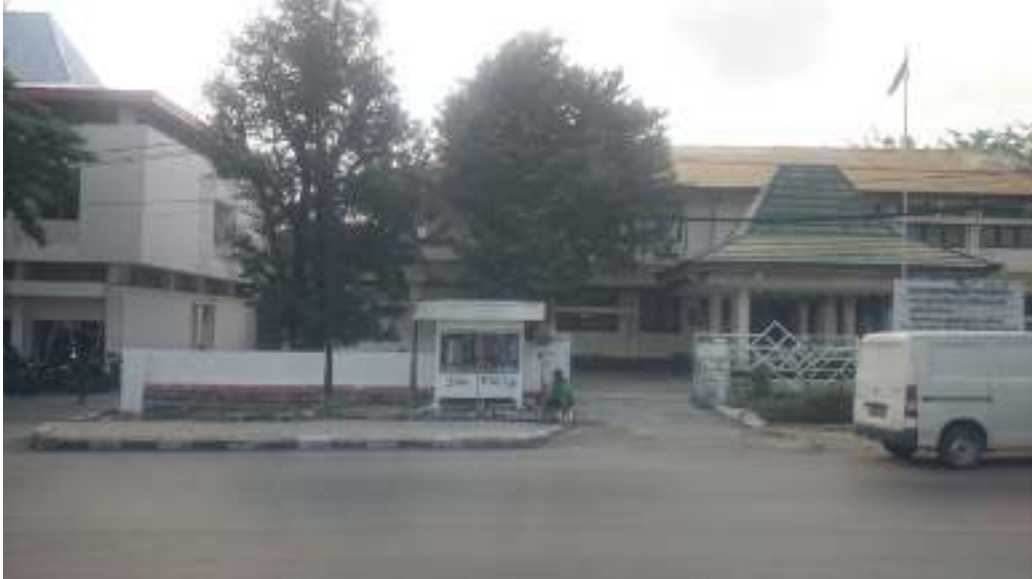
Gambar 5 Tampak depan kios gerobak angalae di jalan palap Kota Kupang.
