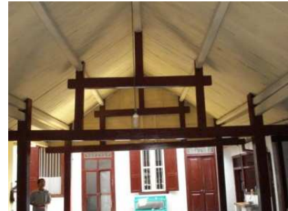
Gambar 14. Analisa bentuk konstruksi atap arsitektur tradisional Tionghoa (Sumber : Data lapangan)
